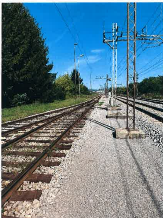
Slika 2: Obstoječe stanje železniške proge Zidani Most - Šentilj – d.m., gledano v smeri Maribora
