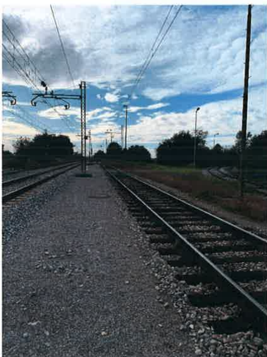
Slika 4: Obstoječe stanje železniške proge Zidani Most - Šentilj – d.m., Predvidena lokacija medtirnega perona
