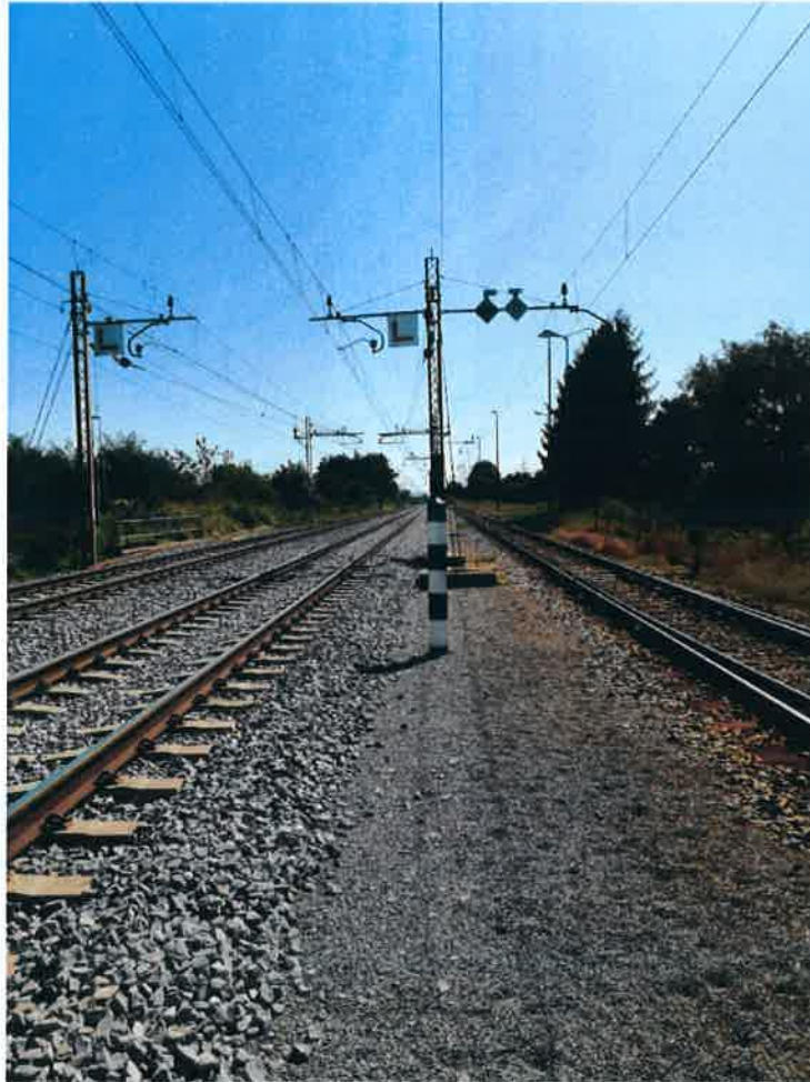
Slika 1: Obstoječe stanje železniške proge Zidani Most - Šentilj – d.m., gledano v smeri Hoč
