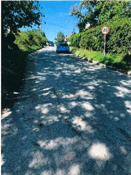
Slika 6: Obstoječa cesta do podvoza
